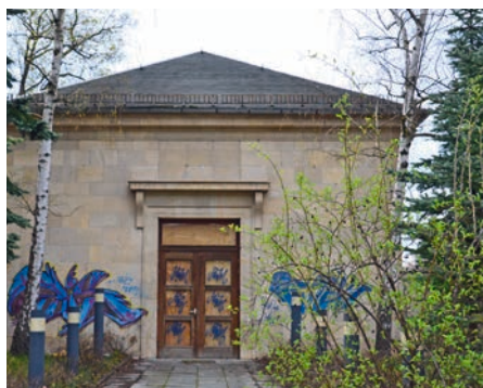
Trostlos: Der Haupteingang des ehemaligen Funkhauses ist mit Brettern vernagelt.
