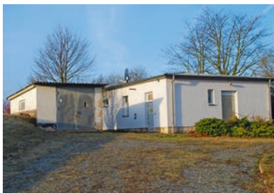
Das Stationsgebäude Weimar Belvedere wurde vor wenigen Jahren durch einen Container ersetzt, das Foto aus dem Jahr 2012 zeigt noch den alten Zustand
