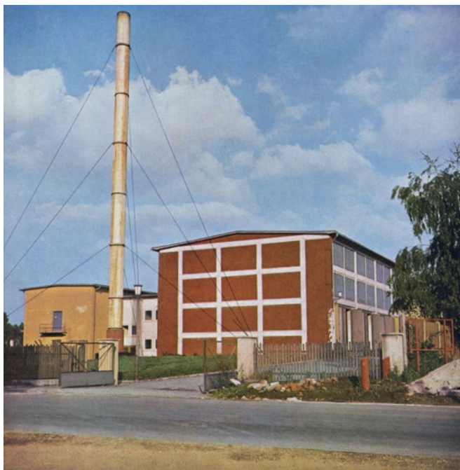
Dieselskraftwerk Hildburghausen, um 1970
