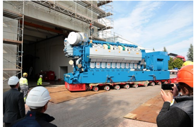
Über eine Speziallafette wird die 13 m lange und 130 t schwere Motor-Generator-Einheit in die Endposition im Maschinenhaus des HKW Bad Salzungen der TEAG gezirkelt, 2017
