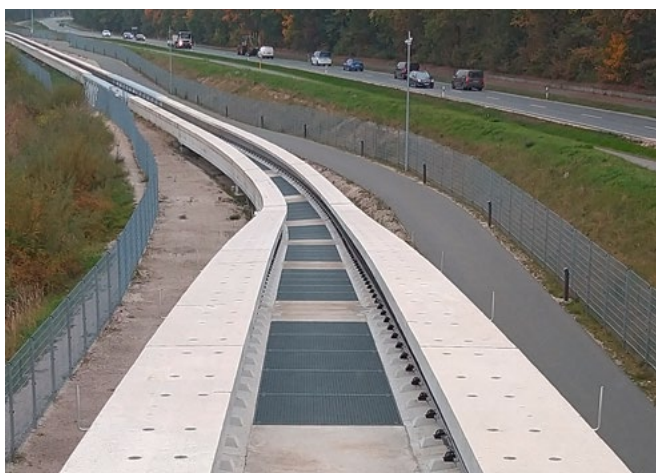
Der Fahrweg der TSB-Versuchsstrecke in Sengenthal, 2022 (Bildquelle: Stephan Hloucal)
