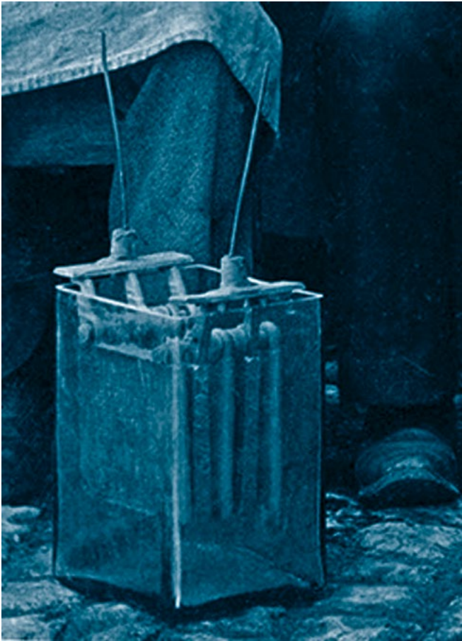
Blei-Säure-Akkumulatorzelle, Tudor, 1882 (Quelle: https://musee-tudor.lu/elektrizitaet/ )
