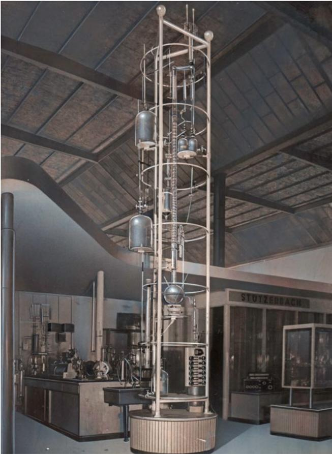
Messestand des Glaswerkes Stützerbach mit halbertechnischer Destillationsapparatur, um 1955
