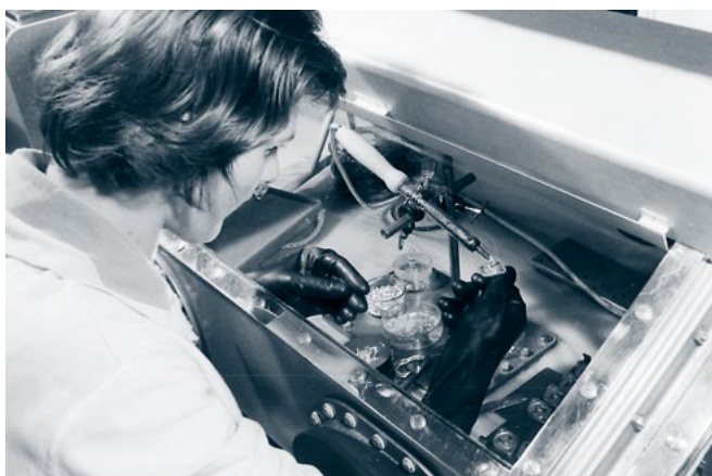
Anlöten der Basis- und Emitteranschlüsse an die Glasdurchführungen, 1961 (FWE-Bildarchiv im Thüringer Industriearchiv)
