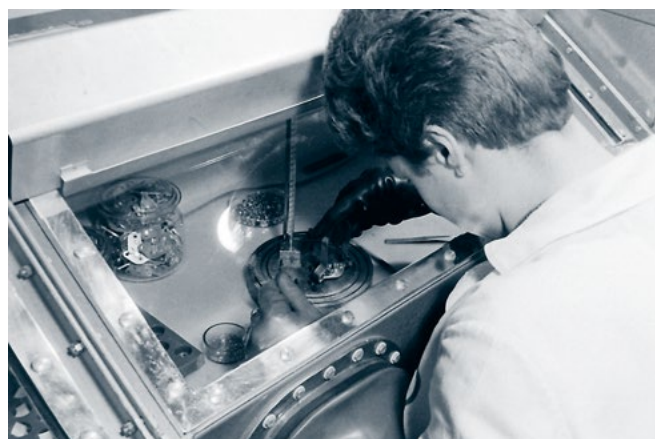
Auflöten der Kollektorseite auf die Grundplatte, 1961 (FWE-Bildarchiv im Thüringer Industriearchiv)
